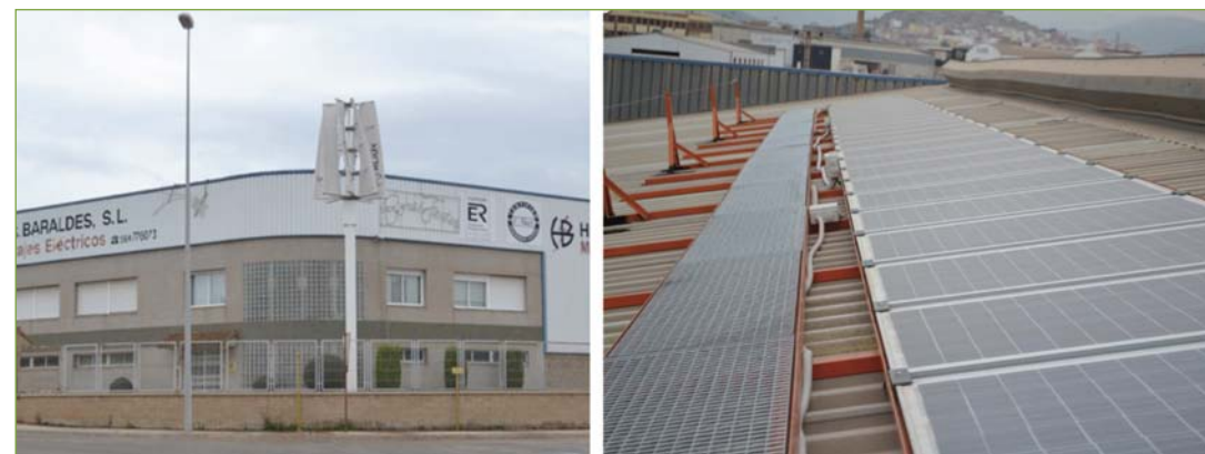
Figura 18. Instalación del sistema híbrido.
