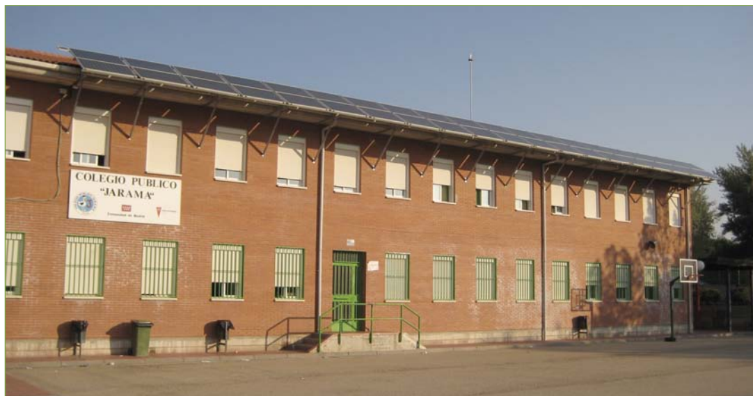
Figura 16. Instalación solar fotovoltaica en Colegio Público "Jarama".
