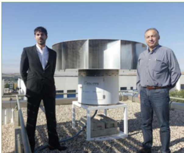
Figura 17. Modelo EOLI FPS1000 en la cubierta del edificio municipal.
