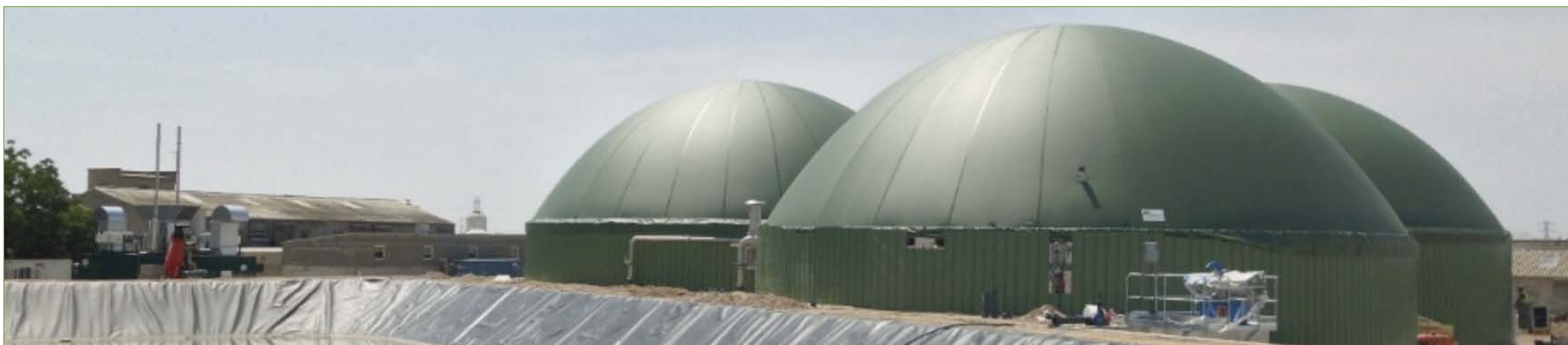
Planta de biogás de Torregrossa.
